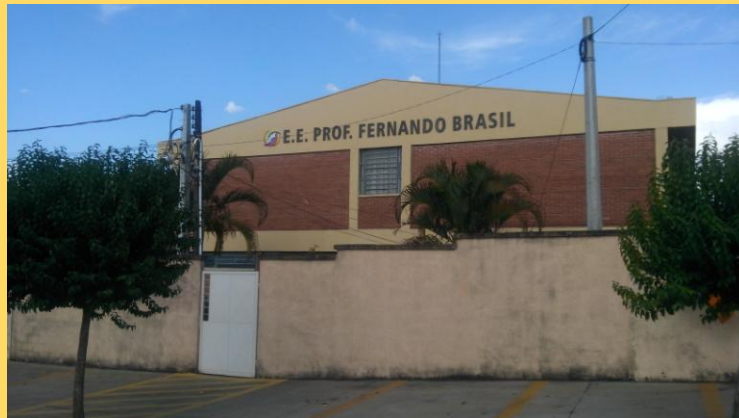
Instalações atuais da Unidade Escolar.
